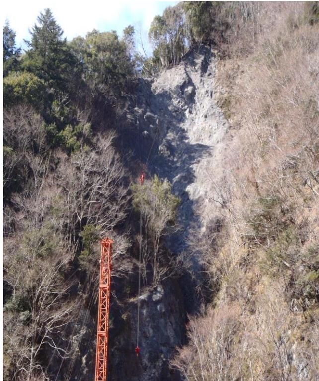
【工事完成・・・マイティネット工法 + 厚層基材吹き付け (法面緑化)】
