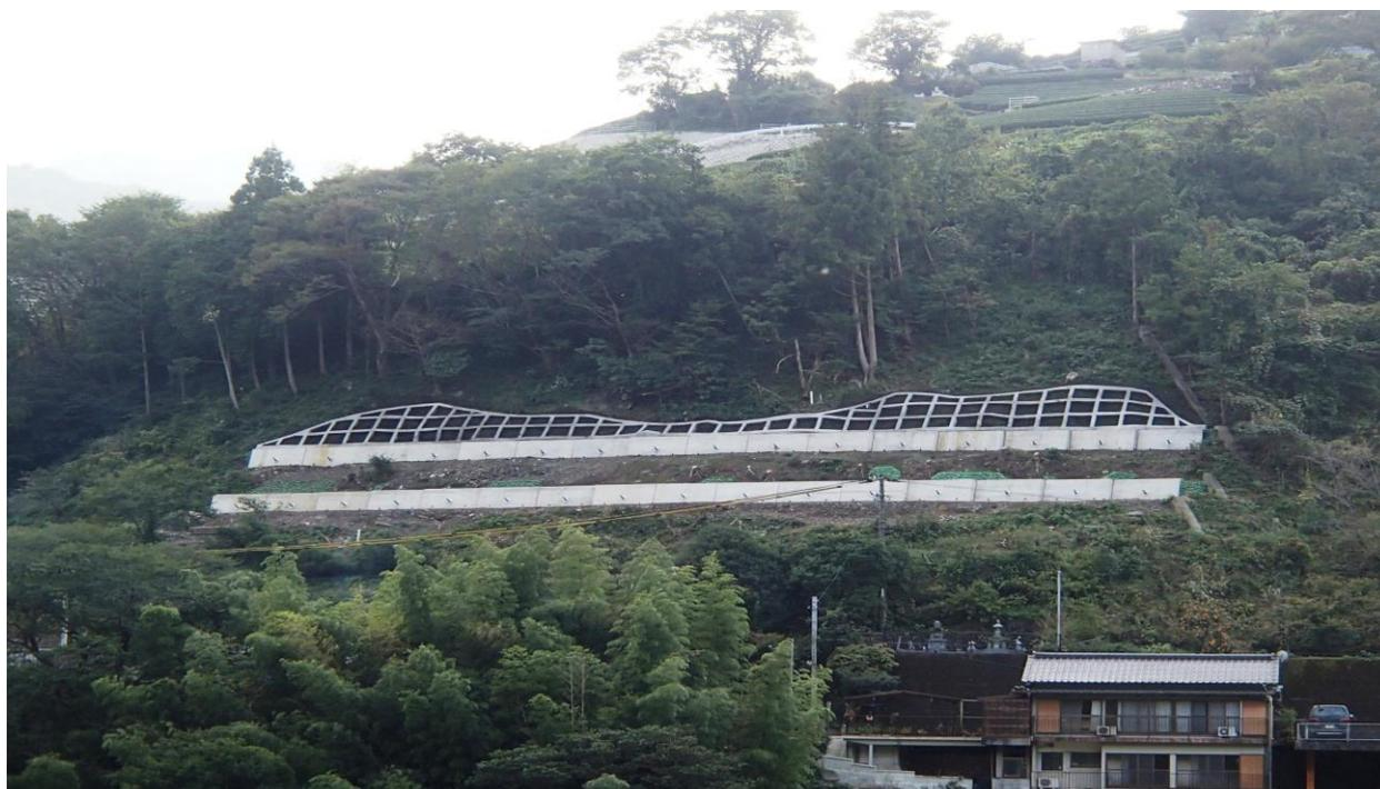
※地すべり防止工事において、地すべりを防止するためのアンカー工事を実施しましたが、上部法面にひび割れがあり、現場吹付け法枠工法を提案して法面の安定と緑化を行い、併せて景観の向上を図ることができました。
