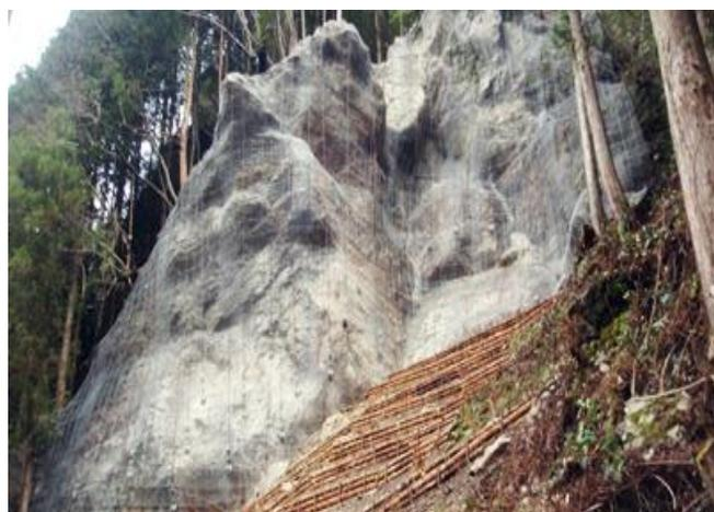
※落石防止を図るため、地山の改変（切土）を行うことなく岩塊を固定することにより法面の安定を図ることができました。
