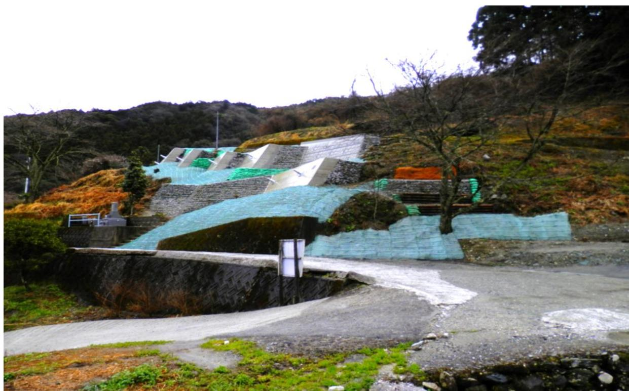
※地すべり防止工事において、地すべりを防止するためのアンカー工事を実施しましたが、切土法面が露出し土砂の流出の懸念があったため植生土のうを設置し、法面の緑化を行うことで景観の向上を図りました。
